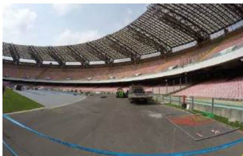
跑道尚在施工中
