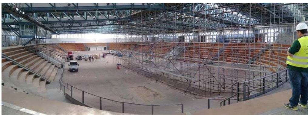
體操場館內部整修情況
