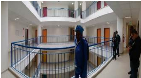
宿舍內部天井
