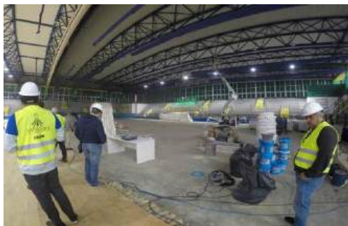
比賽場木質地板鋪設工程進行中
